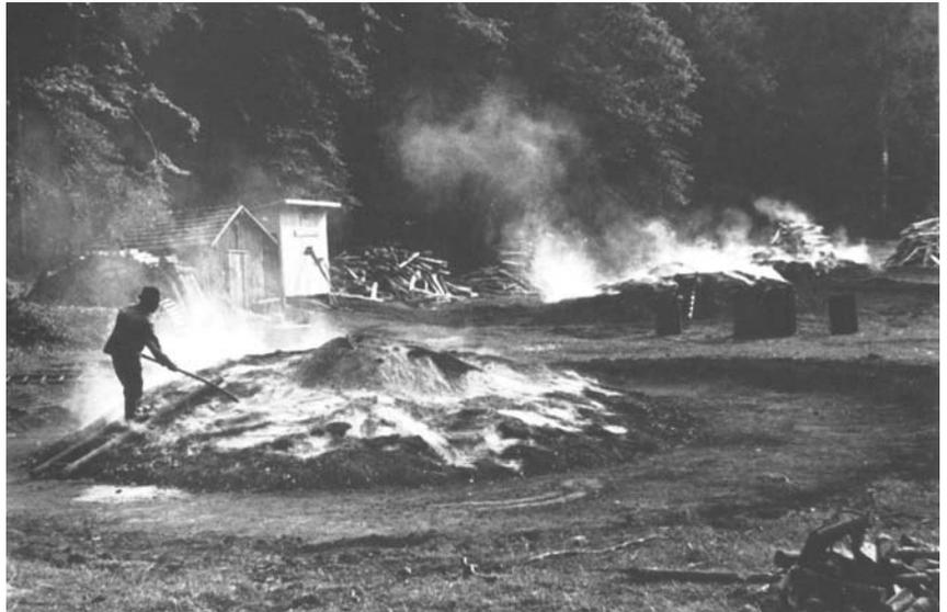
werbe, das in der Nähe der Hüttenwerke ansässig war. Die Holzkohle wurde auf "fliegenden" (wechselnden) Kohlplatten direkt im Wald produziert. Die Kohlplatten waren kreisrunde, ebene Bodenplatten, die in der Mitte erhöht waren (damit das Wasser ablaufen konnte), auf denen die Meiler aufgestellt wurden. Sie waren ca. 6 - 8 m im Durchmesser. Die Ausbeute eines Meilers lag bei ca. 50% des Volumens und bei ca. 20% des Gewichtes.
